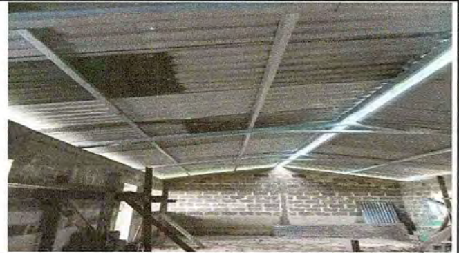
Foto 8: Sustitución de estructuras metálicas aula de preprimaria y segundo primaria
