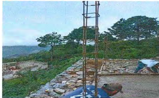
Foto 10: Colocación de columnas área de corredor de primero, tercero y cuarto primaria.
