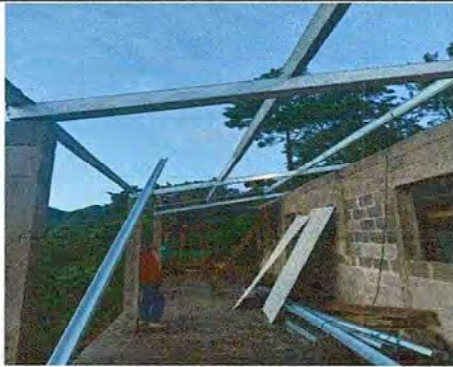
Foto 7: Sustitución de estructuras metálicas corredor aula de preprimaria y segundo primaria.
