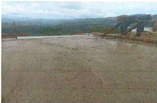
Foto 9: Rehabilitación de área de corredor aula de primero, tercero y cuarto primaria.
