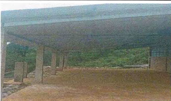
Foto 11. colocación de columnas, costaneras y láminas área de corredor de primero, tercero y cuarto grado.
