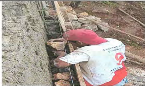
Foto 2: colocacion del solera en el muro de contencion.
