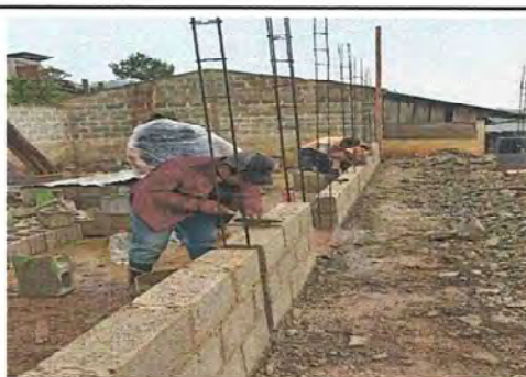
Foto 4: Inicio de colocacion de block en la parte frontal del aula de preprimaria y segundo primaria.
