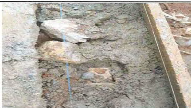
Foto 3: 80 % de avance en la colocacion del muro de contencion.
