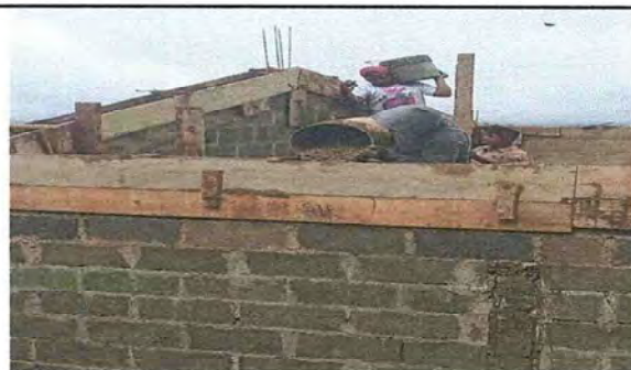
Foto 6: Colocacion de solera aula de preprimaria y segundo primaria.
