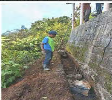
Foto1: inicio de colocacion del muro de contencion aula de preprimaria y segundo grado.
