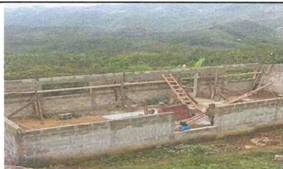
Foto 5: Colocacion del lugar de ventanas y puertas aula de preprimaria y segundo grado.
